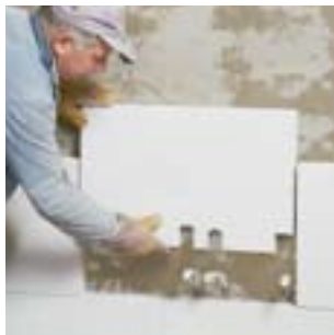
Le mortier léger est étalé sur toute la surface du panneau au moyen d'une truelle.
